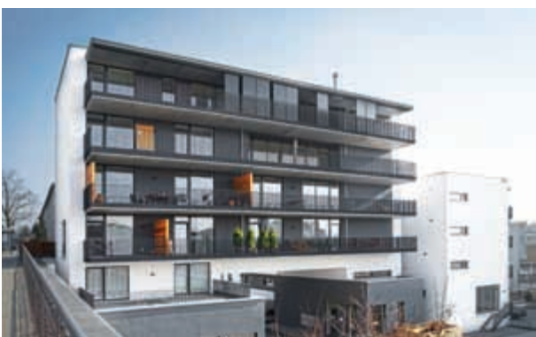
Kassel, Samuel-Beckett-Anlage Mehrgenerationenwohnhaus Bauherr: Vereinigte Wohnstätten 1889 e. G., Kassel Planung: Clemens Kober Architekt BDA, Kassel
