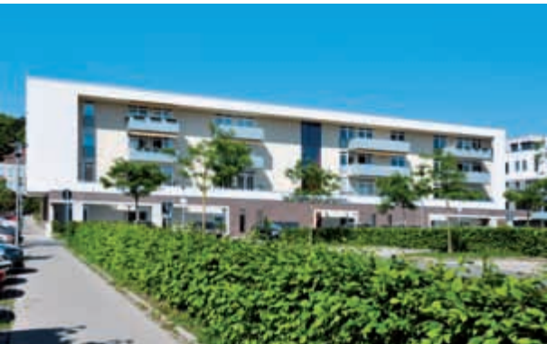
Kassel, Samuel-Beckett-Gelände Altenwohnen Bauherr: Vereinigte Wohnstätten 1889 e. G., Kassel Planung: HHS Planer + Architekten AG, Kassel
