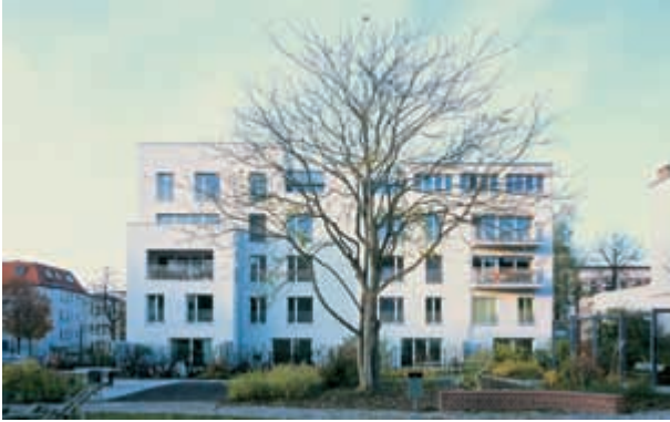
Berlin, Meyerbeerstraße / Mahlerstraße Eigentumswohnungen im Geschossbau, Baugruppe 32 Bauherr: Baugruppe Meyerbeerstraße GbR mbH, Berlin Planung: dmsw Bürogemeinschaft für Architekten und Landschaft, Berlin
