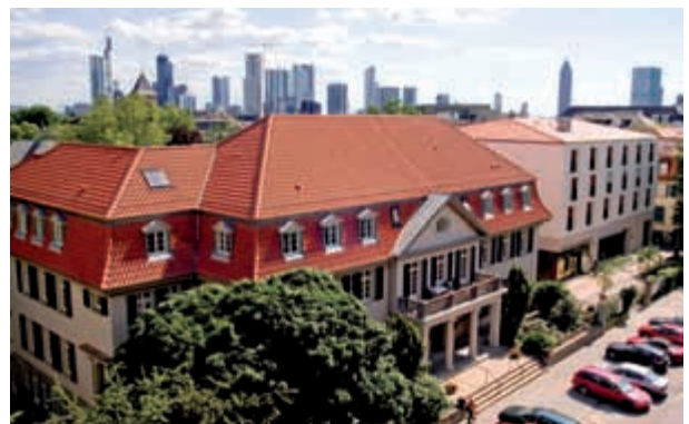
Frankfurt am Main, Cronstettenstraße Sanierung und Neubau, Bauherr: Frankfurter Diakonissenhaus, Frankfurt a. M. Planung: B&V Braun Volleth Architekten, Frankfurt a. M.
