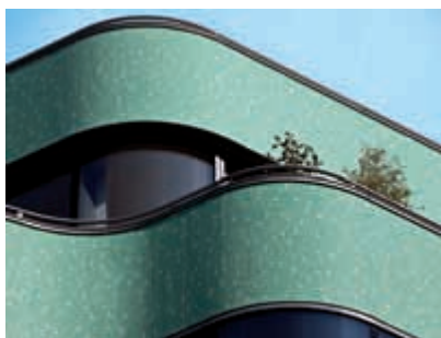
Verwendung von dauerhaft beständigen, selbstreinigenden Glasmosaikfliesen
