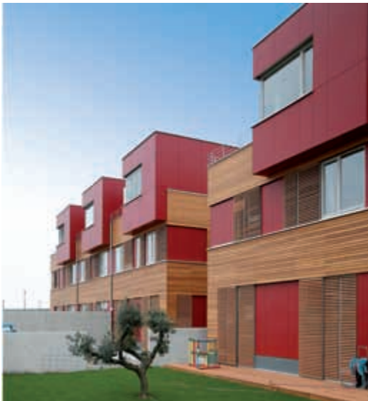
Frankfurt am Main, Richard-Breitenfeld-Str. Reihenhäuser zur Miete Bauherr: Bauherrengruppe, Frankfurt a. M. Planung: bb22 architekten + stadtplaner, Frankfurt a. M.
