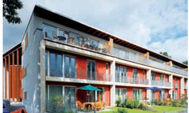
Dortmund, Generationenweg Generationenübergreifendes Wohnen Bauherr: Spar- und Bauverein e. G., Dortmund Planung: Post & Welters Architekten & Stadtplaner GmbH, Dortmund
