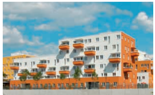
München, Wohnquartier Theresienhöhe Mietwohnungen im Geschossbau Bauherr: GWG Städtische Wohnungsgesellschaft München mbH Planung: Steidle Architekten, München
