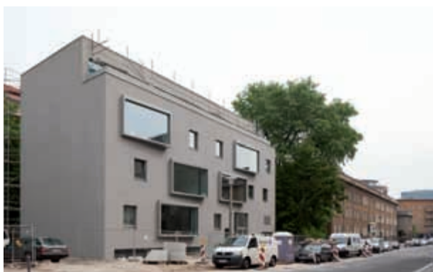
Berlin, Linienstraße Eigentumswohnungen im Geschossbau Bauherr: WEG Linienstraße 23, Berlin Planung: BCO Architekten, Berlin
