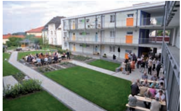
Ilmenau, Richard-Bock-Straße Wohnanlage Sophienhütte Bauherr: WBG Ilmenau / Thür. e. G., Ilmenau Planung: Erdmann-Johannes Steffani, Architekt, Ilmenau
